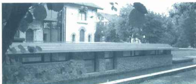
En primer plano aspecto de la remodelación del antiguo edificio.
