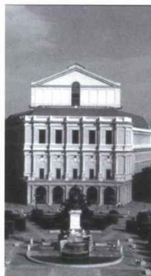
Fachada del Teatro Real de Madrid.
